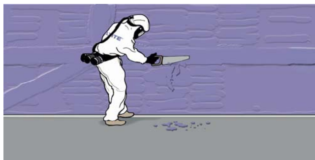
Figure 13 : Ecrêtage des surépaisseurs
